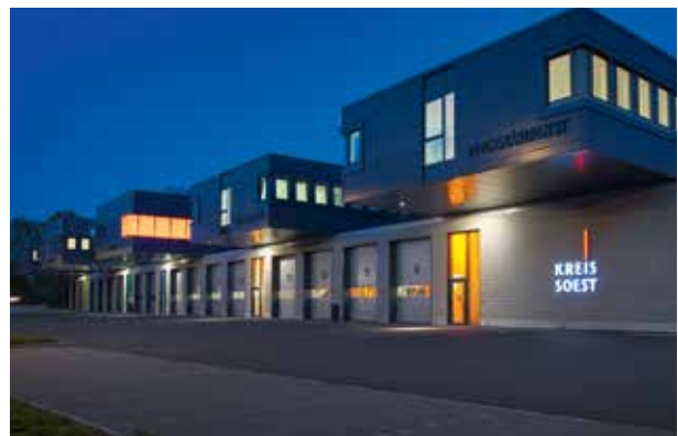
Neubau Rettungszentrum Kreis Soest: Lehde erstellte den Rohbau und lieferte alle Stahlbetonfertigteile.
